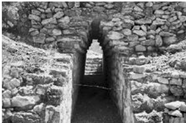
Илл. 6. Фальшивый свод в комплексе Органера-Шочипала. Стил Мескала. Поздний классический период. Герреро
