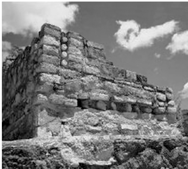
Илл. 8. Пример использования каменных вставок в архитектурном оформлении сооружения («западно-мексиканский руст»). Стиль Мескала. Культура Органера-Шочипала. Герреро
